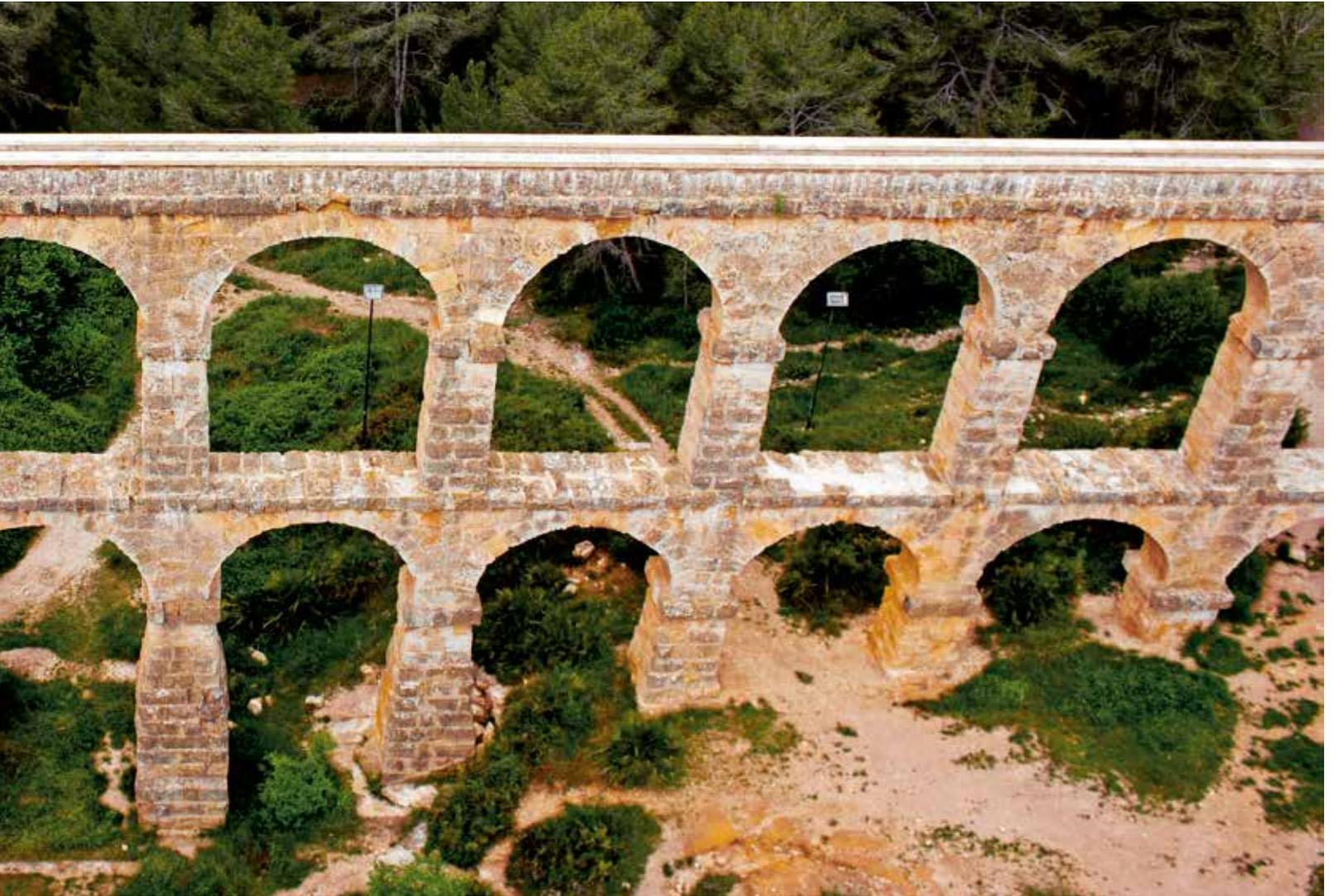
una arquería compleja de dos pisos, compuesta en la parte inferior por once arcos de tipo piramidal formando un primer cuerpo de sostén sobre el que apoya una segunda hilera de veinte y cinco arcos adaptada a los taludes laterales. La cota superior ya era suficiente para atravesar el barranco
