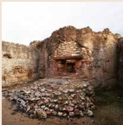
El calor necesario para calentar salas y bañeras era producido por grandes hornos de leña alimentados continuamente. La salida de los gases ardientes del horno se producía por una apertura trasera dirigida a un doble suelo sostenido por columnas de losetas cerámicas bajo el pavimento de la sala contigua. Pepo Segura
