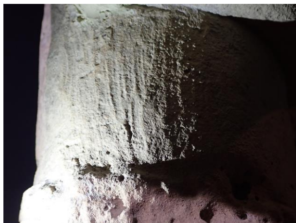
Fig. 34 Tracce di impiego di uno scalpello piatto.
