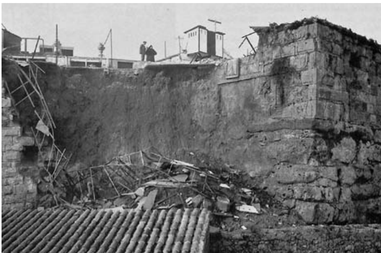
Fig. 15: Derrumbe del extremo del lienzo adosado a la torre de S.Magí ocurrido el 19 de febrero de 1932. Este derrumbe producido por filtraciones desde un convento adosado a la muralla, dejó al descubierto el relieve de la Minerva que decoraba la torre. Las tierras que se aprecian en el interior del lienzo derrumbado corresponden al relleno interior de adobes (Foto Real Academia de la Historia)
