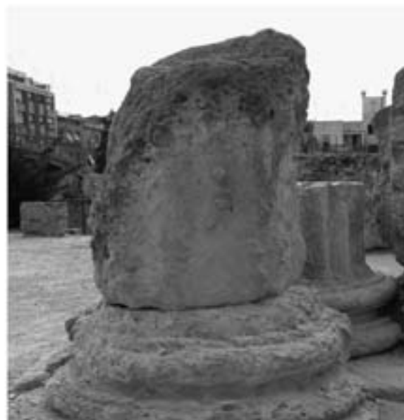
Fig. 144: Basas áticas sin plinto realizadas en piedra local estucada de las columnas de la basílica jurídica (diám. imoscapo: 86 cms).
